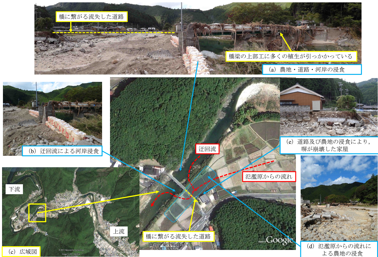
図-1 熊野市五郷町における迂回流及び氾濫原からの水の流れによる河岸・道路・農地の浸食
