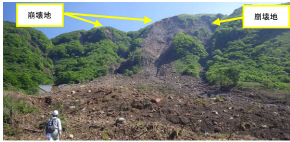
図-3 上の小屋川2の崩壊地と堆積土砂
