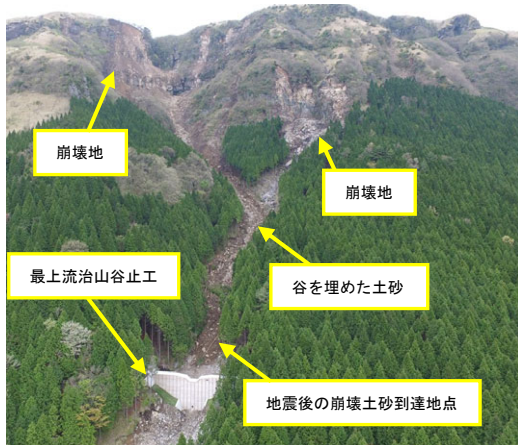
図-5 上の小屋川3の地震直後の状況(4月18日撮影)
