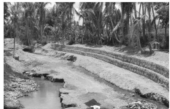
図 5 蛇籠導流堤の設置状況 (2011) 3)
