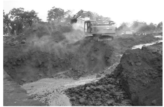
図 4.1 導流流路の施工状況 (2011) 3)
