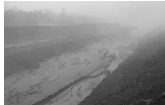
図 4.2 導流流路完成時の状況 (2011) 3)
