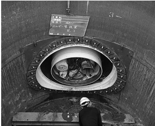
写真-8 ホルダー管推進完了状況
