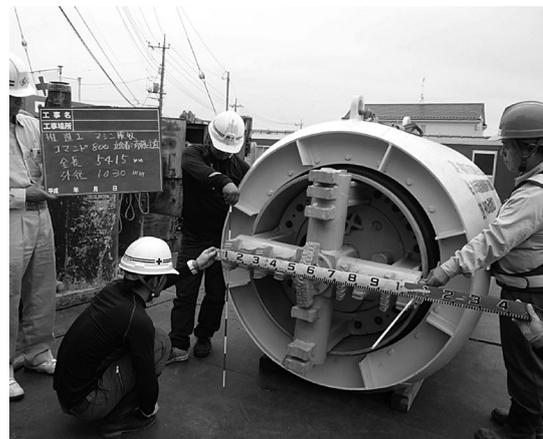
写真-6 ホルダー管を外装した掘進機
