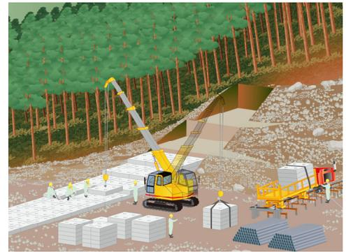
図-3 鋼管補強コンクリートブロック堰堤
