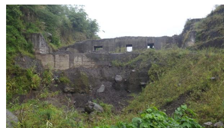
図5 副堰堤下部までの掘削事例
