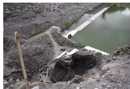
図6 護岸工背面側までの掘削事例
