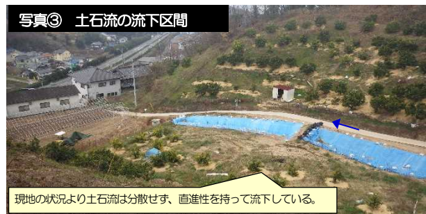
図-6 土石流が流下した区間の状況
