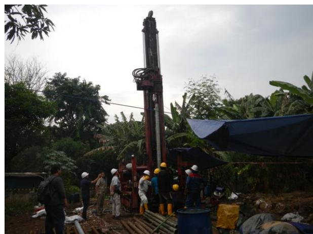
図-5 結束されたスライド管と外管の建込み
