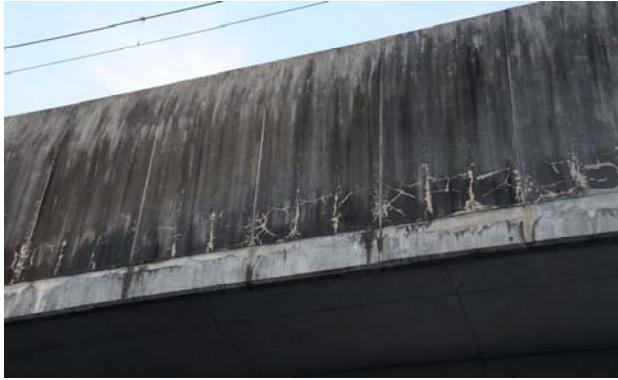
図-19 傾斜を有するコンクリート製高欄の汚れ
