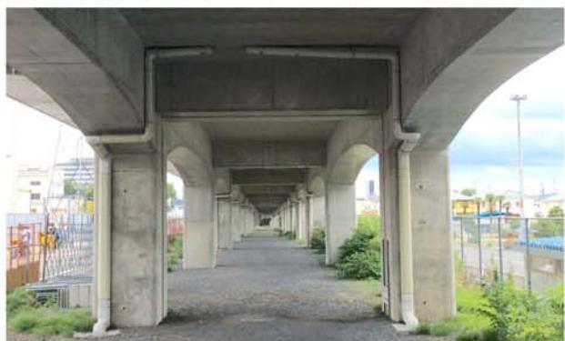
図-11 排水管の配置箇所
