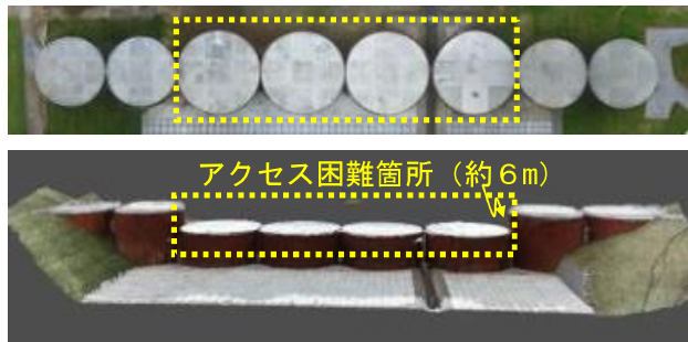
図5 対象砂防施設Bの平面及び正面写真
