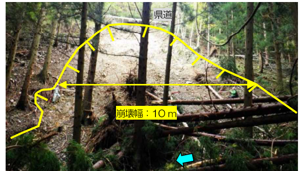
写真-2 崩壊地の状況
