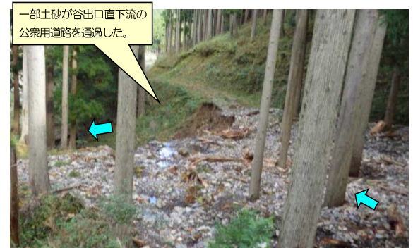
写真-5 堆積区間の状況(上流より)
