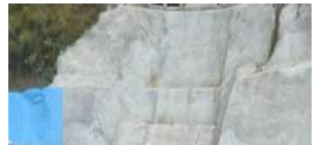
図-3 吹付モルタルによる保護
