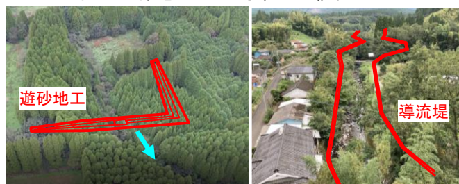
図-2 現地状況写真
