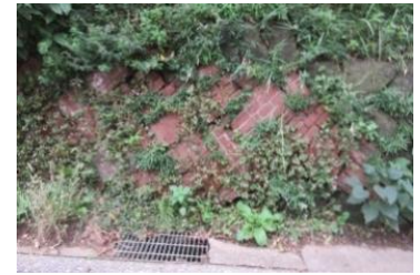
写真-2 がれきレンガ擁壁
