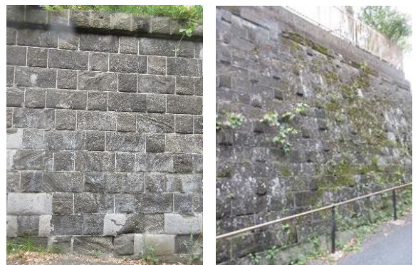
(1) 千代ヶ崎砲台(明治中期) (2) 汐入小学校(昭和初期) 写真-1 ブラフ積擁壁
