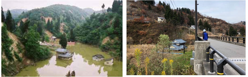
図-3 (左) 斜面崩壊による芋川の閉塞で水没した木籠集落(2005.5.31)と (右) 橋桁下に保存された震災遺構としての家屋(2019.11.24)
