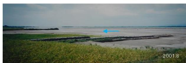
図-9 ラカンディイ川沿いに設置された鉄線籠水制
