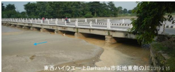
図-2 河床が上昇し橋脚フーチングが埋没、桁下高が低減した
