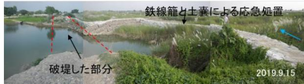
図-5 2019 年 7 月洪水で破堤したラル・バカヤ川左岸堤防
