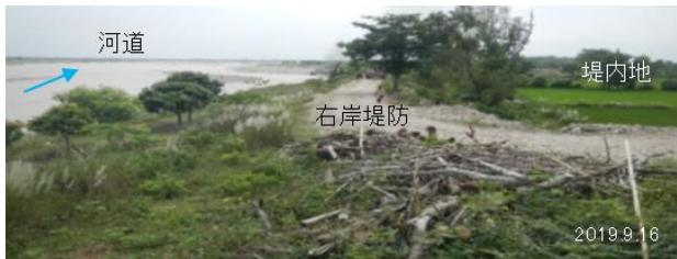
図-4 カマラ川では河床が堤内地盤高より高くなっている
