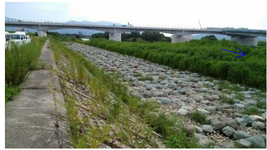
図-19 照査対象護岸① 洗堀対策実施後の状況 (令和1年8月27日 RiMaDIS巡視記録より)
