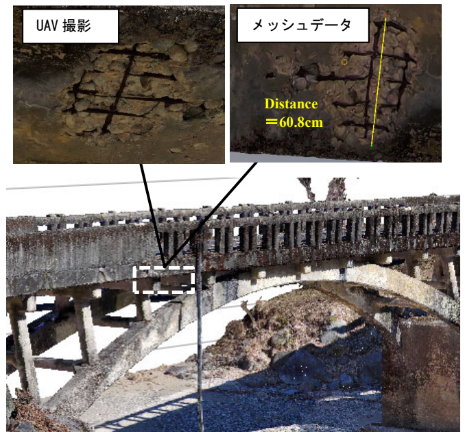
図-3 構造物全体の3Dモデル化例
