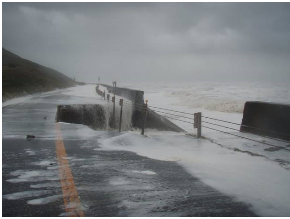
写真-1 2009年台風18号による海岸護岸と県道の被災（2009年10月8日撮影）
