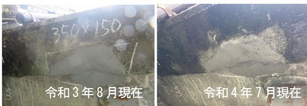
図-7 簡易補修箇所の継続的なモニタリング
