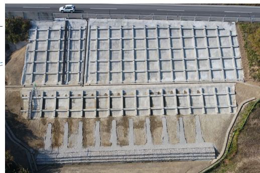
図 2 補強工事完了後の写真
