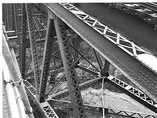
写真-5 架け替え前の第一白川橋梁のラティス構造
