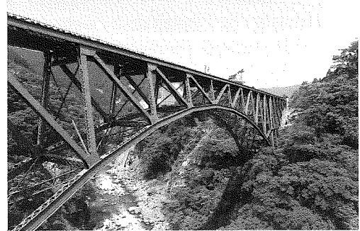
写真-1 第一白川橋梁
