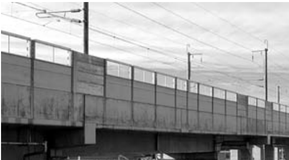
写真-8 新幹線橋の防音壁
