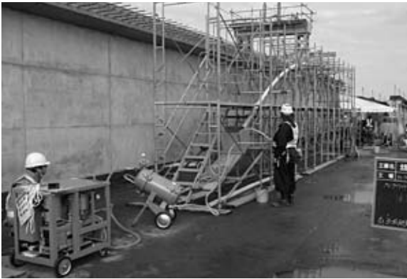
写真-6 グラウト充填性試験
