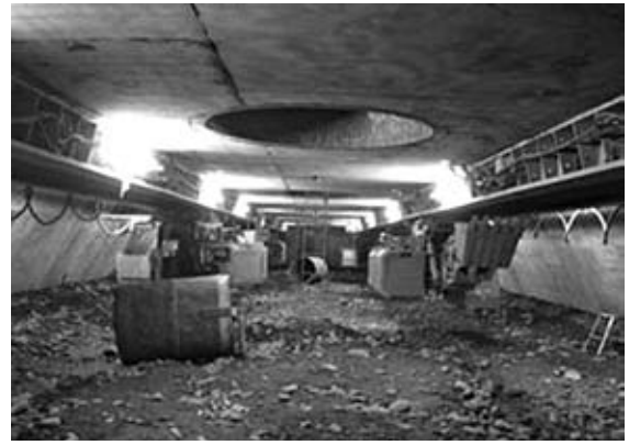
写真-4 ケーソンの掘削
