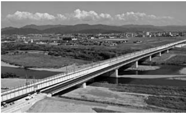
写真-1 九頭竜川橋梁と新九頭竜橋
