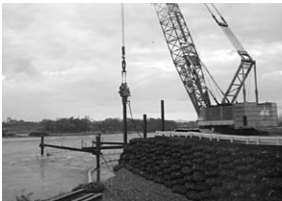
写真-3 仮栈橋H鋼杭の打設
