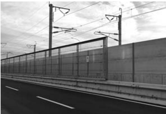
写真-9 道路橋の積荷転落防止柵
