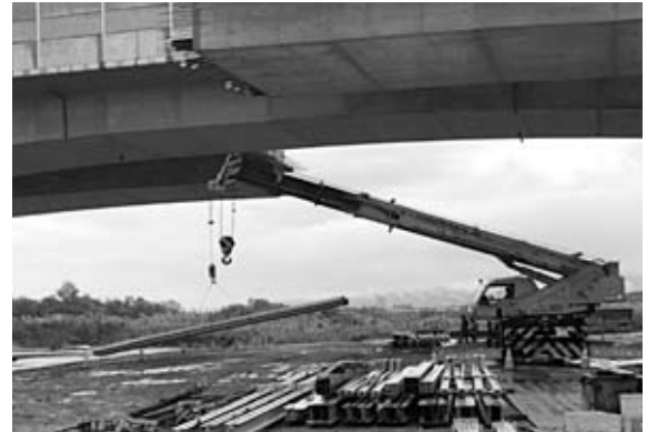
写真-7 移動作業車の荷振り
