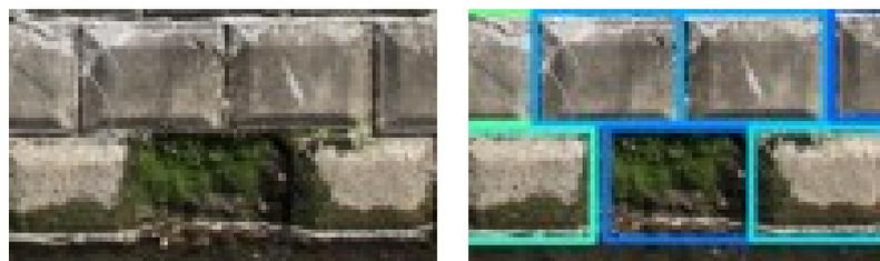
図-18 護岸ブロック外れ（左：元画像，右：検出結果）
