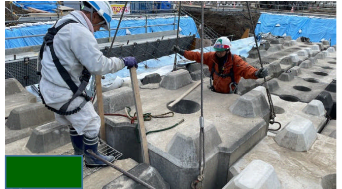
図8 施工状況（ブロックの設置）
