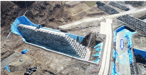
図7 本堰堤の施工状況（令和5年3月時点）
