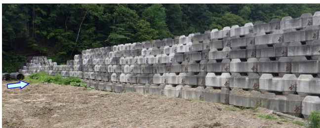
図2 緊急的に整備したブロック積砂防堰堤
