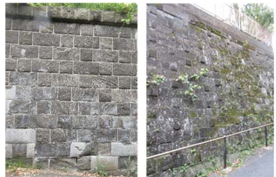
(1)千代ヶ崎砲台(明治中期) (2)汐入小学校(昭和初期) 写真-1 ブラフ積擁壁
