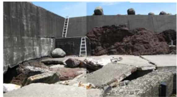
写真-4 岸壁エプロン部の被災状況
