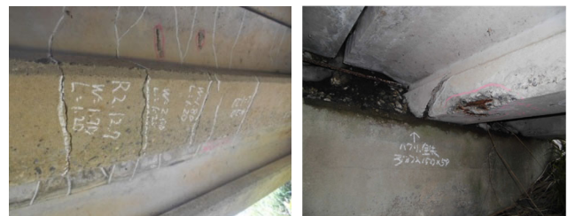
図 2 曲げひび割れ
