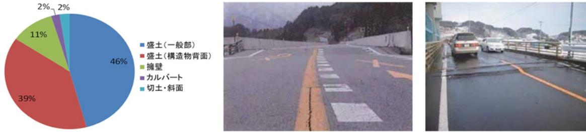
図1 東北地方太平洋沖地震における道路土工構造物の被災状況と構造物背面盛土の段差状況<sup>1)2)</sup>
