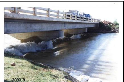
図-13 日本の無償資金効力で新設されたカンボジア国道 6A 号線橋梁での 2000 年洪水時における水理現象<sup>3)</sup>
