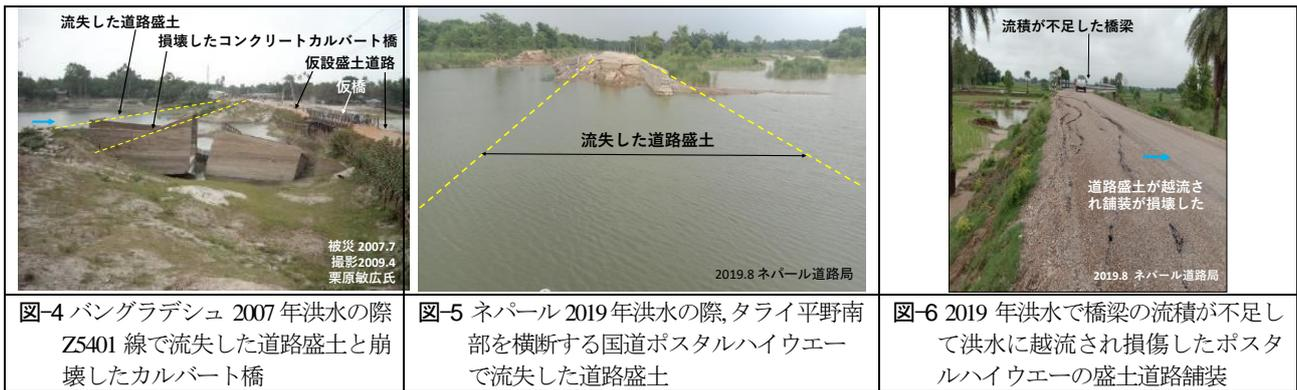
図-4 バングラデシュ 2007年洪水の際Z5401線で流失した道路盛土と崩壊したカルバート橋 被災2007.7 撮影2009.4 栗原敏広氏 図-5 ネパール 2019年洪水の際、タイ平野南部を横断する国道ポスタルハイウエーで流失した道路盛土 2019.8 ネパール道路局 図-6 2019年洪水で橋梁の流積が不足して洪水に越流され損傷したポスタルハイウエーの盛土道路舗装 2019.8 ネパール道路局
