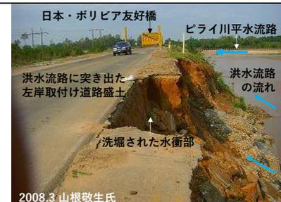
図-12 ボリビア国道 4 号線の日本・ボリビア友好橋にて、2008 年 3 月洪水で発生した盛土取付け道路の洗堀
