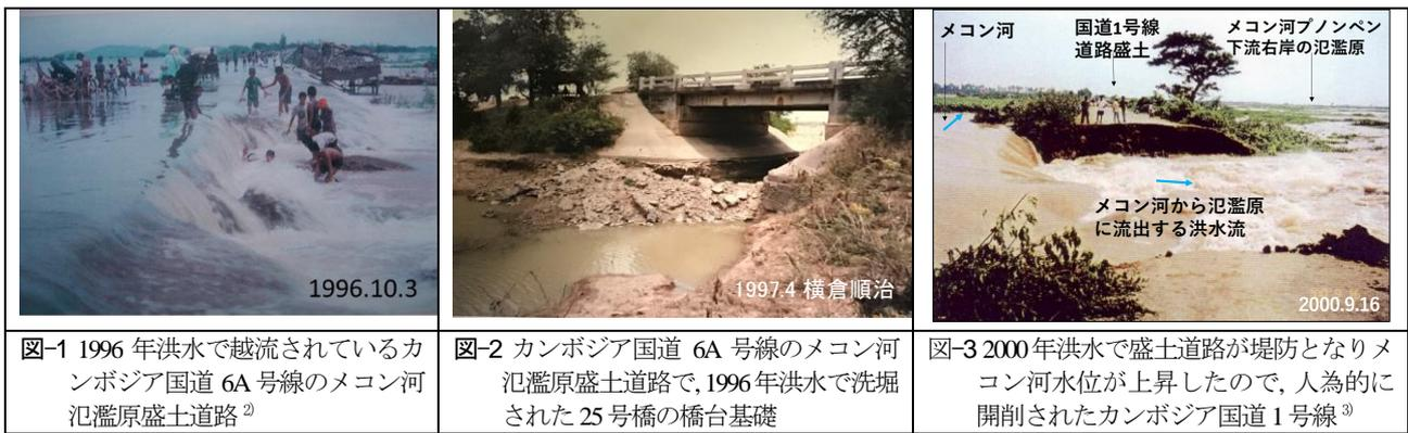
図-1 1996年洪水で越流されているカンボジア国道6A号線のメコン河氾濫原盛土道路<sup>2)</sup> 図-2 カンボジア国道6A号線のメコン河氾濫原盛土道路で、1996年洪水で洗掘された25号橋の橋台基礎 1997.4 横倉順治 図-3 2000年洪水で盛土道路が堤防となりメコン河水位が上昇したので、人為的に開削されたカンボジア国道1号線<sup>3)</sup> 2000.9.16
