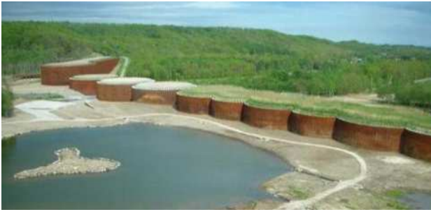
写真2 鋼製セル型砂防堰堤（錦多峰川2号遊砂地）
