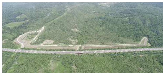
写真1 土堰堤（苫小牧川遊砂地）
