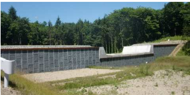
写真4 鋼製DW砂防堰堤（小泉の沢川1号砂防堰堤）
