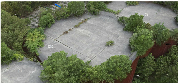
図 3 C10セル天端（UAV・目視で評価）
