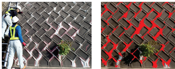
図5 現地計測状況(左)と同箇所の検出結果(右)
