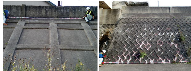
図2 張り護岸(左)と積み護岸(右)の例
