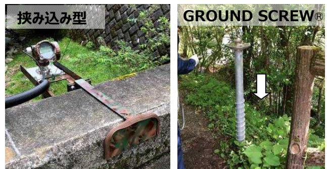
図-1 推奨施工方法（水位計と支柱）
