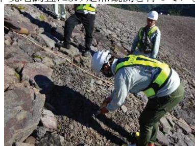
図 1 リップラップ材現地調査状況
