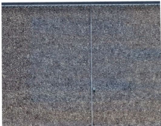
図-3 堤体オルソフォトの例
