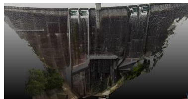
図-7 地上レーザーによる堤体の点群計測結果
