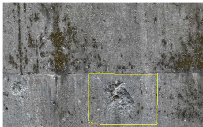
図-1 ポップアウトを含む堤体の三次元復元結果
